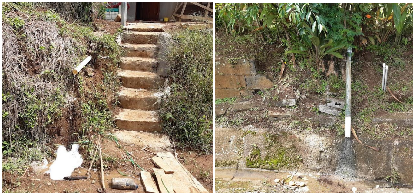
Figura 14. Evidencias del vertido de aguas ordinarias no tratadas al alcantarillado pluvial en la parte media y baja de la subcuenca respectivamente
