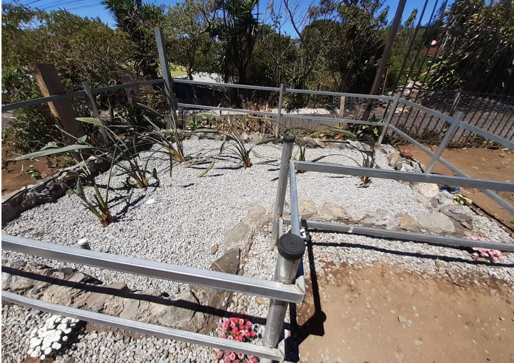
Figura 4. Bio jardinera construida para el tratamiento de las aguas grises de una casa de habitación en el cantón de Poás.
