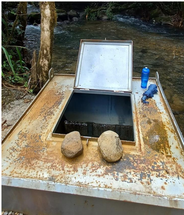
Figura 5. A la izquierda se presenta la toma de agua superficial del río La Paz y a la derecha el interior.
