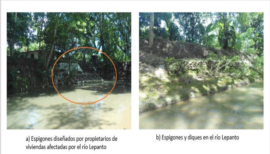
Anexo 3. Estructuras de defensa desarrolladas por algunos pobladores de la comunidad. Elaboración propia, 2020.
