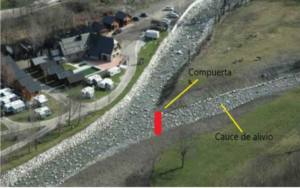
Anexo 4. Vista típica de un cauce de alivio con potencial compuerta. www.iAgua.com
