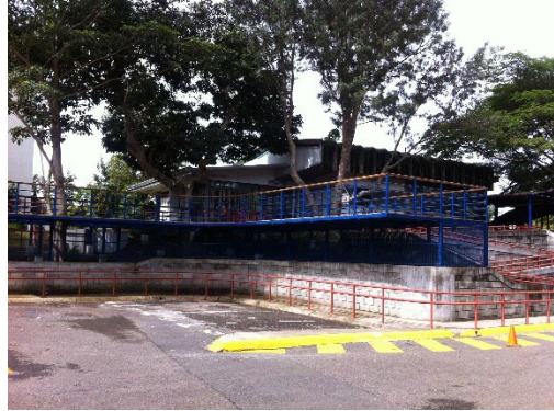
Imagen 7. Registro del proceso de construcción del Deck. Archivo Decanato CIDEA.
