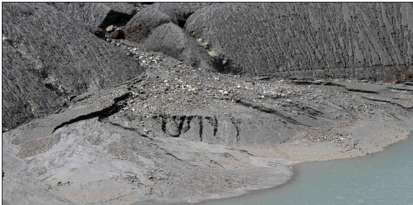
Fig. 3. Acercamiento al abanico de materiales depositados por esta cárcava NW.
