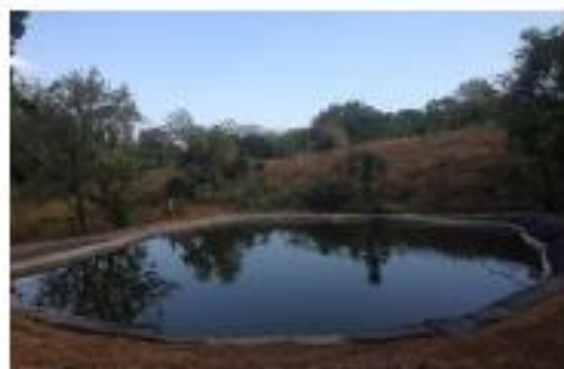
Figura 2. Reservorio en Colas de Gallo, Nicoya, Guanacaste, Costa Rica
