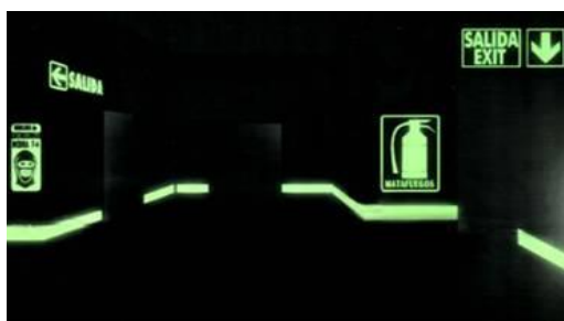
Señalización incandescente emergencias
