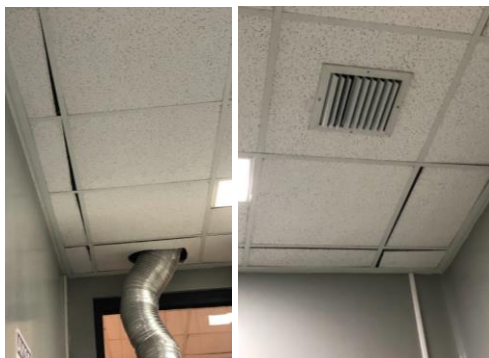
Figura 5.5. Aberturas en el cielo raso del recinto corte macro.
