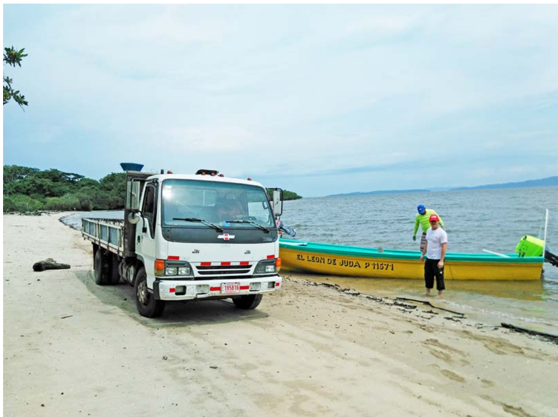
Figura A5. Traslado de los materiales de construcción de Playa Blanca de Chomes a Isla Caballo. NOTA. IMAGEN PROPIEDAD DE LOS AUTORES, TOMADA EL 29 DE AGOSTO DE 2017.
