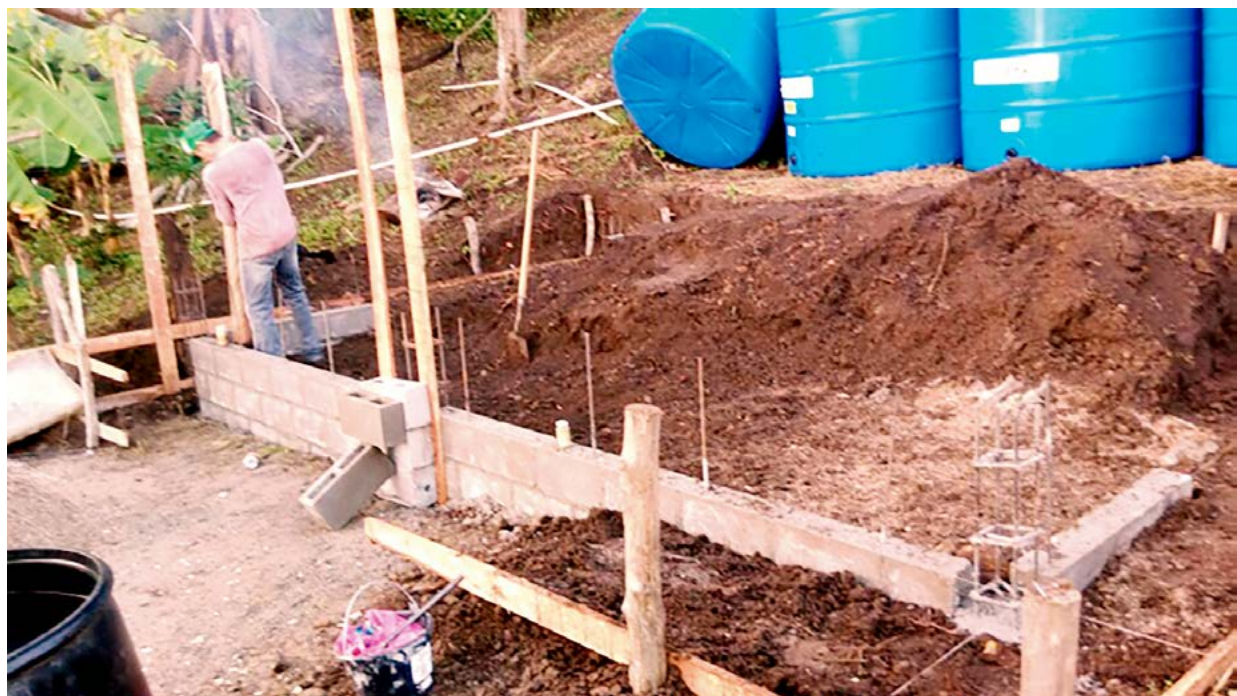
Figura A7. Inicio de la construcción de SCALL en la isla caballo. NOTA. IMAGEN PROPIEDAD DE LOS AUTORES, TOMADA EL 7 NOVIEMBRE DE 2017.
